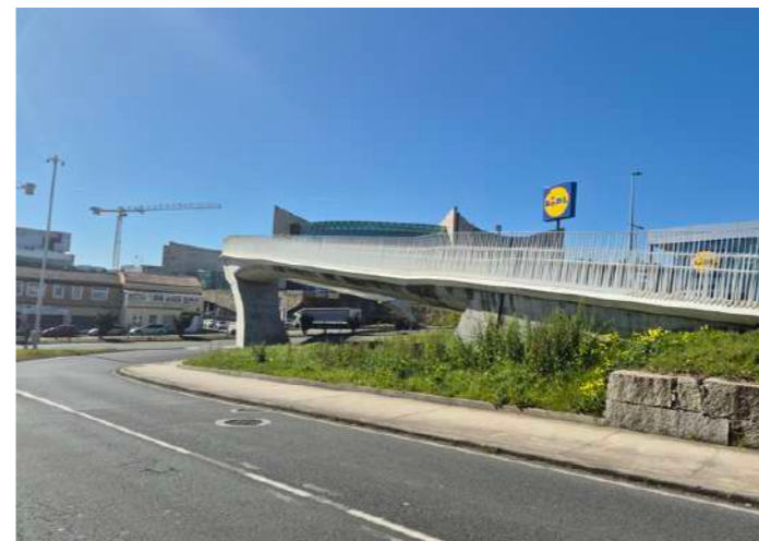
Newton altura pasarela peonil
