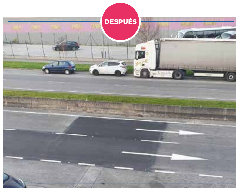
Asfaltado en tramos del vial de bajada de Severo Ochoa
