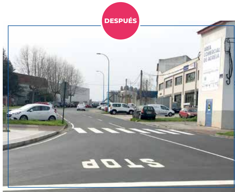
Asfaltado y pintado del cruce Isaac Peral con Gutenberg
