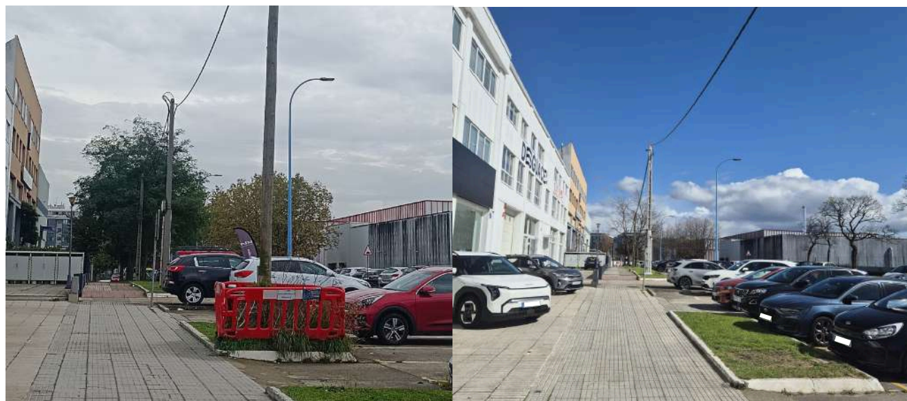
Retirada del machón en la calle Gutenberg y reorganización del tendido eléctrico
