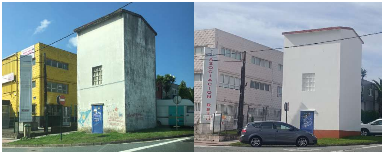
Transformador en calle Pasteur
