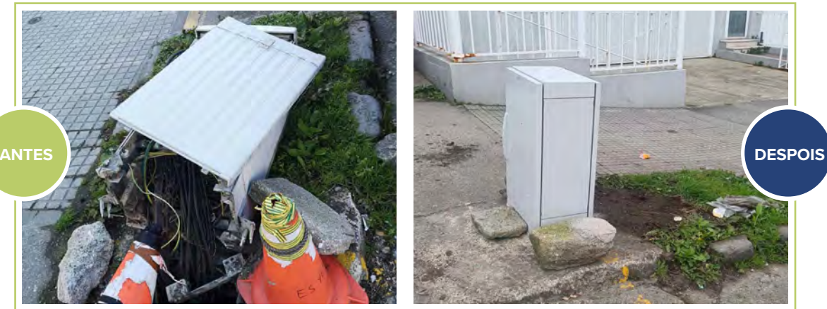
■ Reparación caja R cable en calle Gutenberg
