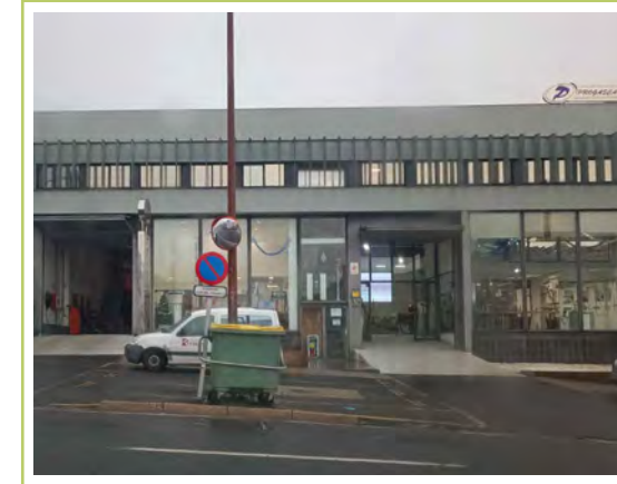
■ Colocación de espello no cruzamento Arquímedes con Pasteur
